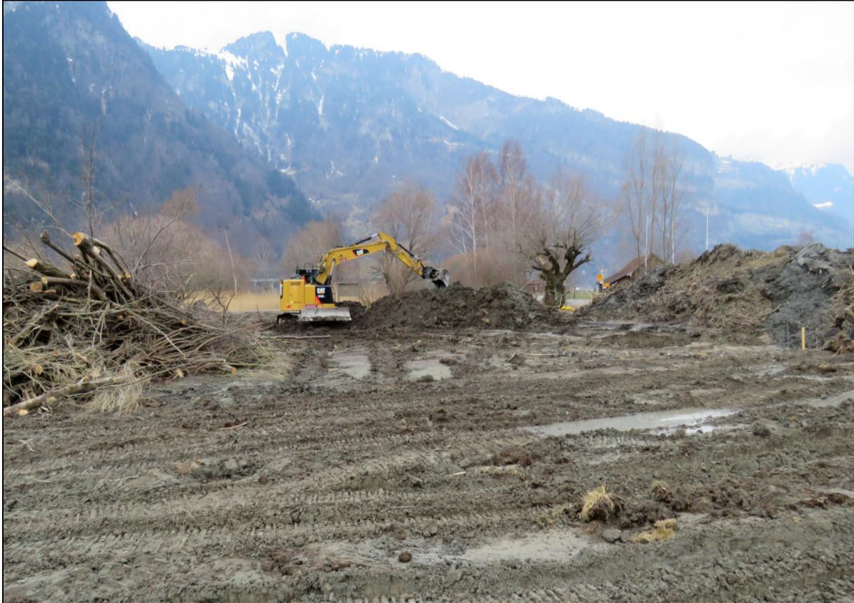
Abb. 11 (6.3.18): Bevor mit dem Aushub begonnen wurde, musste alles oberflächliche Material „entwirrt“ und sortiert werden.
