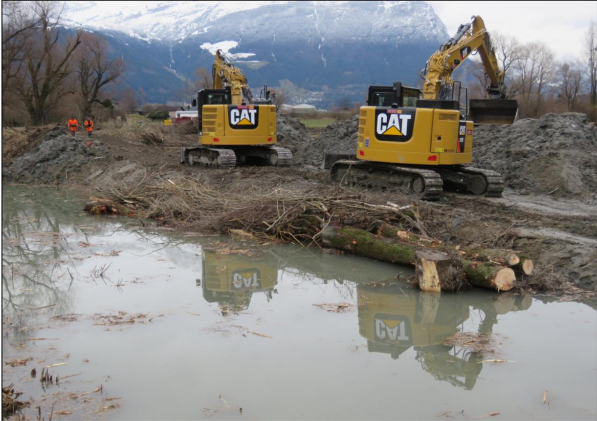
Abb. 13 (7.3.2018): Mit Baumstämmen, Wurzeln und Astmaterial wurden die Fischunterstände konstruiert.
