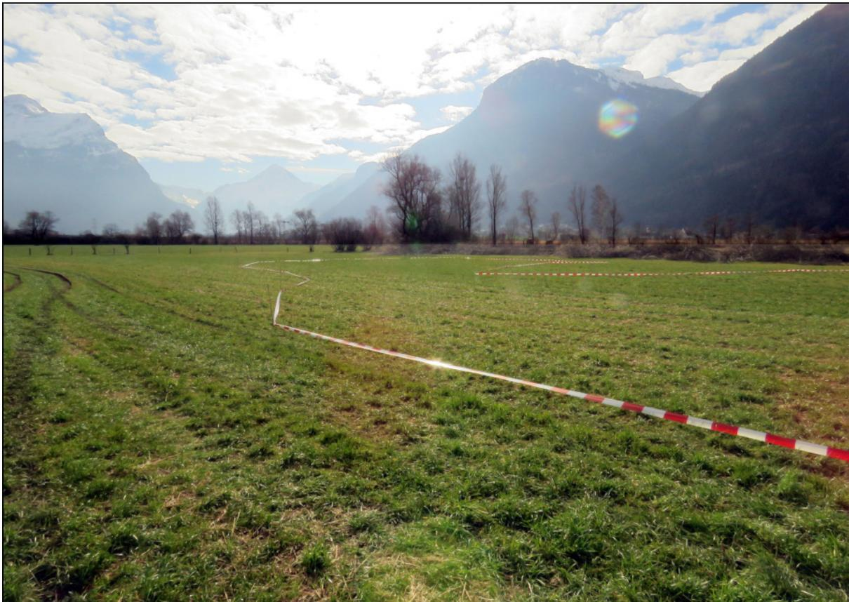
Abb. 5 (31.1.2018): Vor Baubeginn wurde die Mittelwasserlinie markiert und verpflockt.
