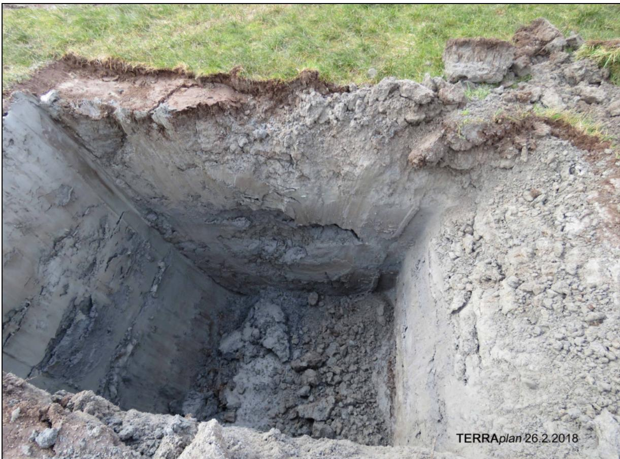
Abb. 10 (26.2.2018): Mit Sondierschlitzten wurde das anzutreffende Material bestimmt.
