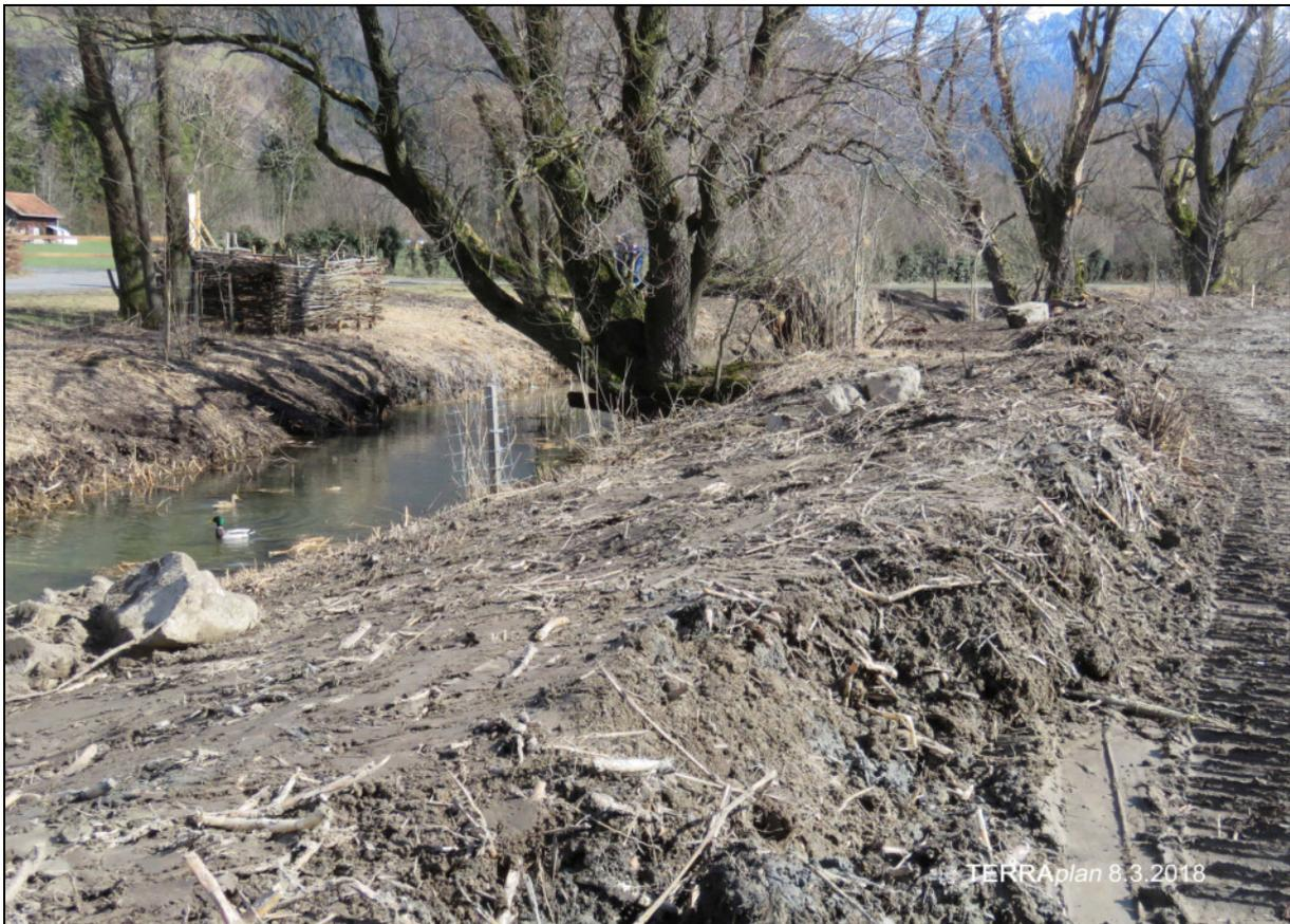
Abb. 14 (8.3.2018): Mit nicht verwertbarem Material wurde der Damm erhöht und zum Teil verbreitert.
