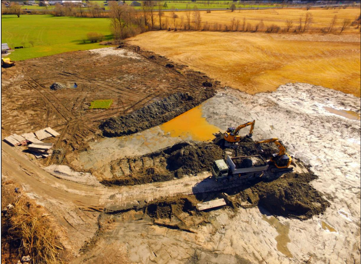
Abb. 17 (23.3.2018): Abtransport des vorher zum trocken bereit gelegten Aushubmaterials.
